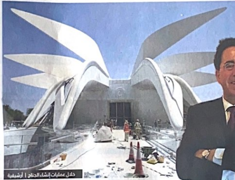
دخل عمليات إنشاء الجناح | الرشيدية
